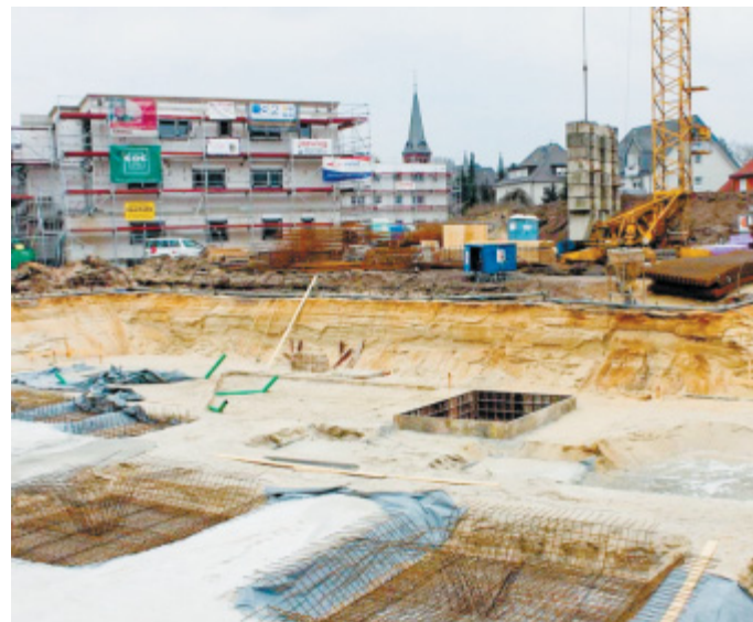
Die Baugrube: Das große Eckgebäude wird nicht nur voll unterkellert, sondern bekommt auch eine Tiefgarage. Im Hintergrund die nahezu fertiggestellten Mehrfamilienhäuser.
