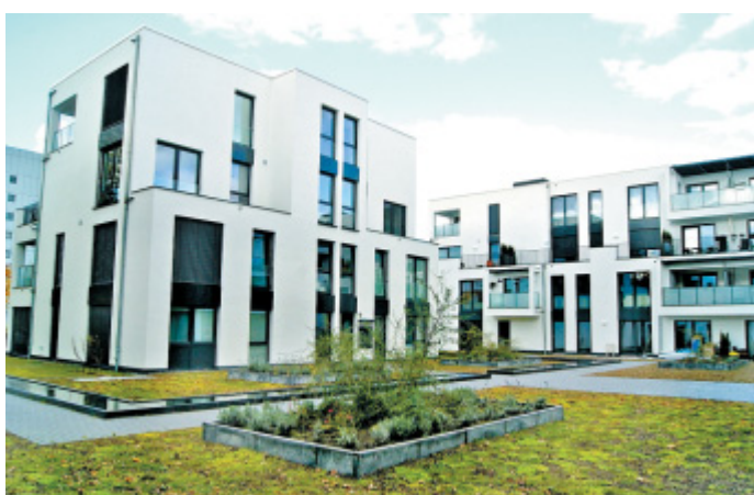
City-Quartier Ravensberger Park: Geradlinig, elegant; moderner Bauhausstil mit Dachgärten in der Innenstadt.
