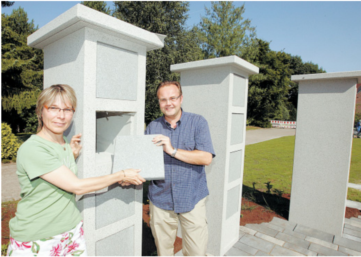
Dezent: Friederike Hennen und Thomas Finke an einer der sieben neuen Urnenstelen. Sie werden mit Granitplatten ohne Schrauben durch einen speziellen Mechanismus verschlossen. „Schrauben korrodieren leicht und die Stele würde schnell unansehnlich“, sagt Hennen.
